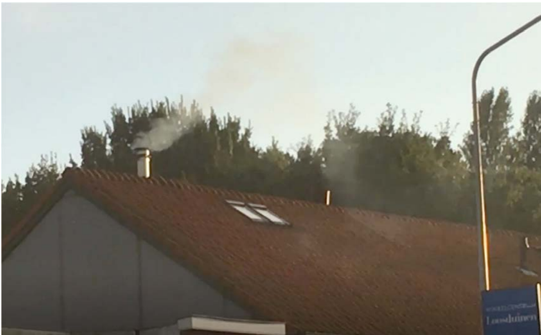
Afbeelding 8.15: Lijwerveffect waardoor de rookpluim omlaag wordt gezogen.
