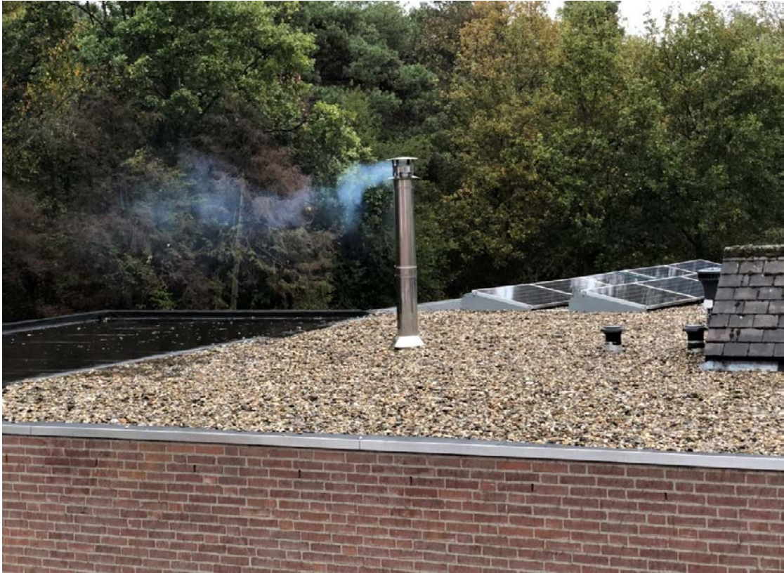
Afbeelding 12.2: Situering Helmond, schoorsteen gezien vanuit slaapkamer nabijgelegen woning (ingezoomd)
